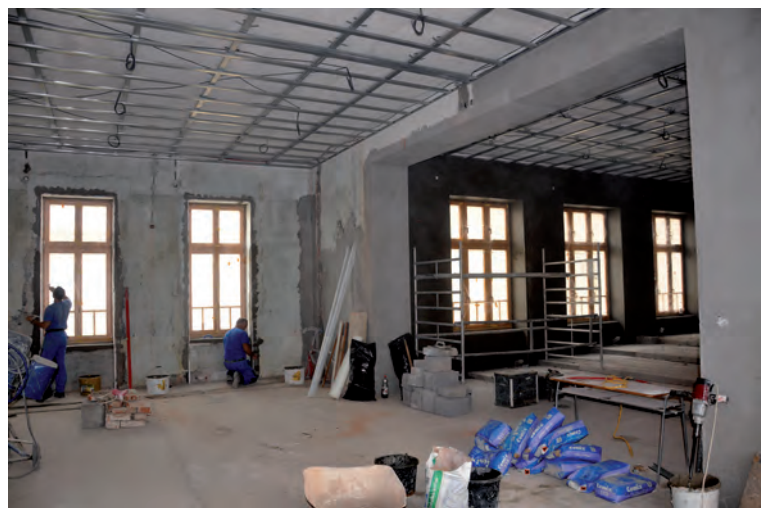
Pohľad na rekonštrukčné práce auly
