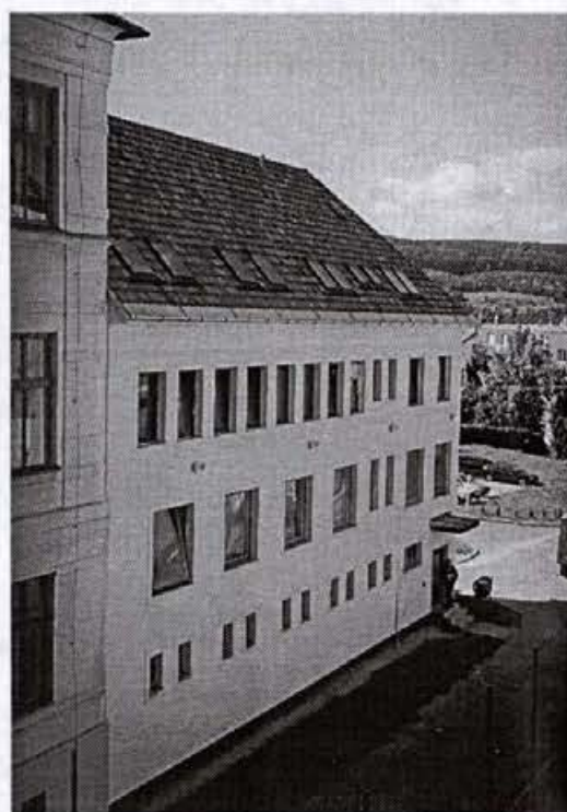
Ďalšou investičnou akciou pripravenou na odovzdanie je rekonštrukcia prístavby R PU na Námestí legionárov č. 3 v Prešove
