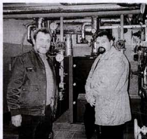
Rekonštrukcia kotolne ŠD na Nám. mládeže v Prešove
