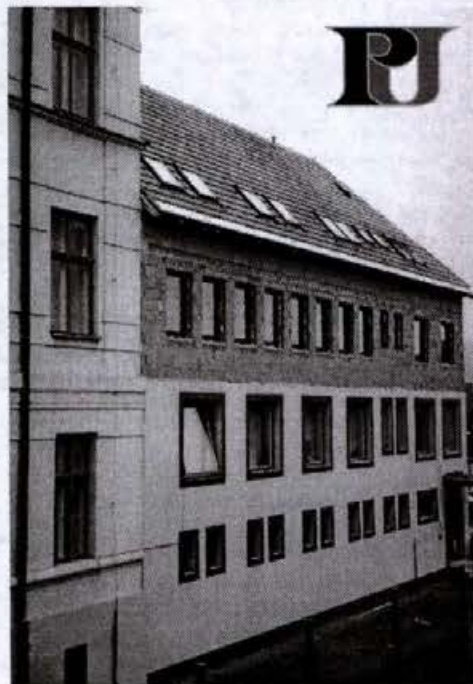
Rekonštrukcia prístavby R PU na Nám. legionárov č. 3 v Prešove
